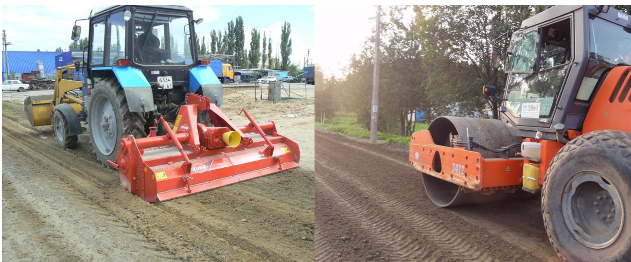
Рис.3 Производство работ по технологии укрепления природных грунтов "ANT"
